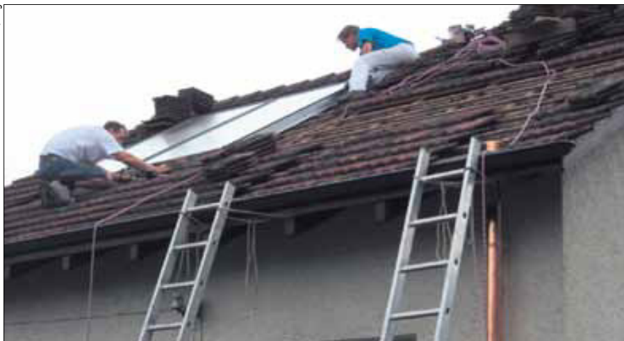
Die Zukunft ist nicht atomar: Auch auf Max Chopards Dach wird ein Solarpanel montiert.
